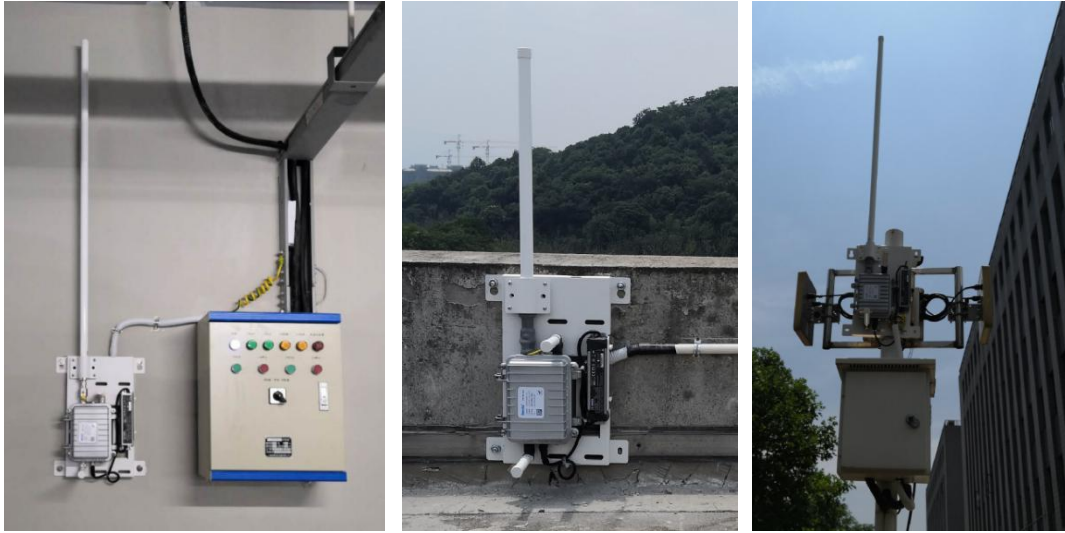
图 6 网关室内、外安装案例
